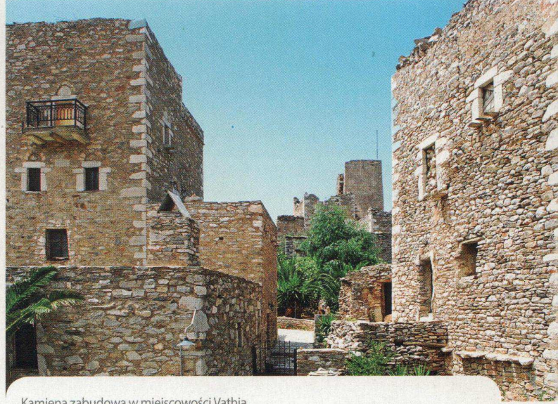
Kamiena zabudowa w miejscowości Vathia
